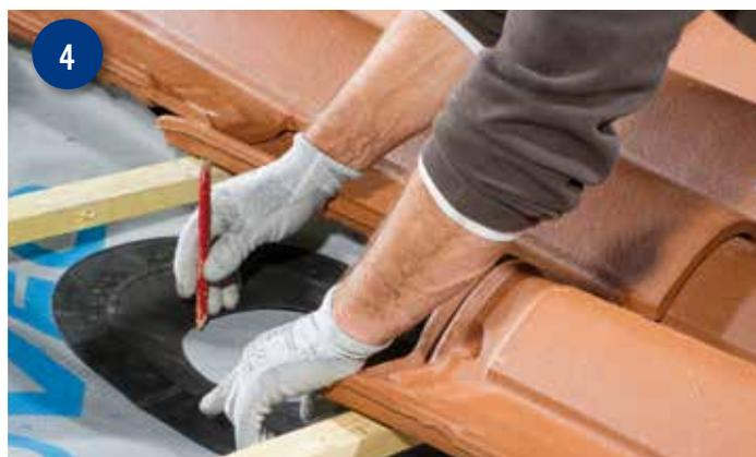
4 A l'aide du repère précédent, positionner la membrane et tracer sa périphérie pour déterminer l'emplacement final, puis tracer la zone de découpe au centre.
