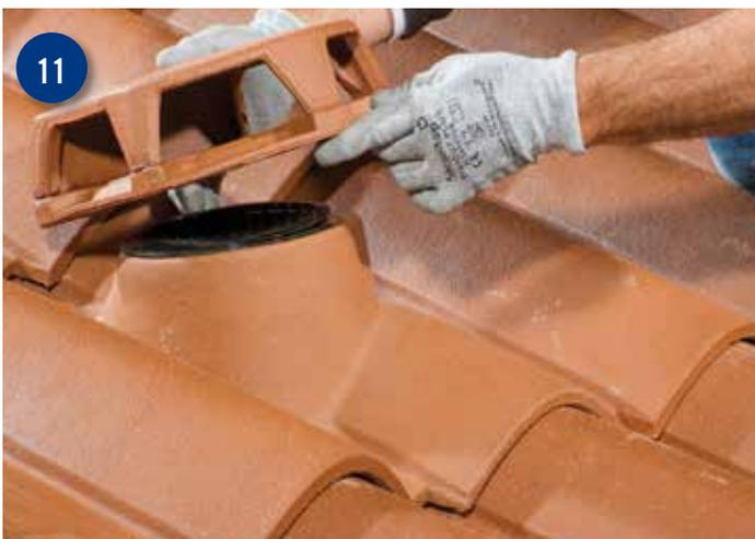
11 Positionner la grille anti intrusion et fixer la lanterne avec un mastic de collage sur la tuile à douille.
