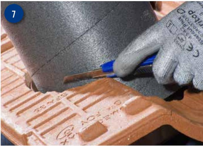
7 La mousse isolante peut être découpée partiellement pour épouser au mieux l'intérieur de la douille.
