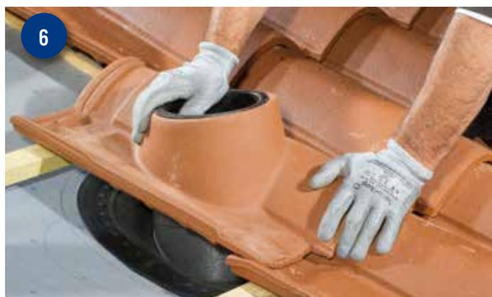
6 Suivant la configuration de pose (largeur utile), prévoir une découpe latérale de la mousse.
