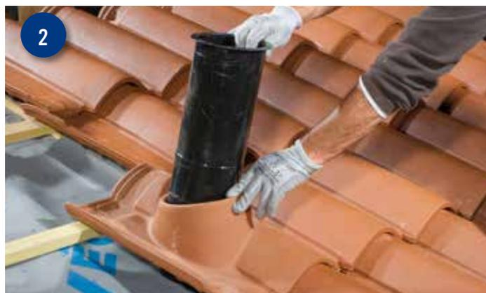
2 Positionner le manchon au centre de la tuile à douille. Le sens d'inclinaison du manchon est indiqué par 2 repères: 2 traits verticaux sur le corps du manchon (placés perpendiculairement à la douille) et 1 flèche sur la collerette (flèche positionnée en direction du faîtage).
