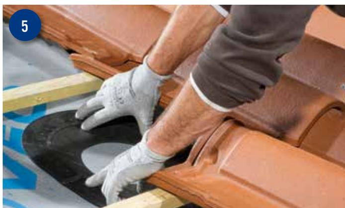
5 Découper la zone de l'écran de sous toiture repérée préalablement (à minima 155 mm de diamètre pour Mangouste 125 et à minima 175 mm de diamètre pour Mangouste 160). Fixer la membrane à l'aide de l'adhésif.
