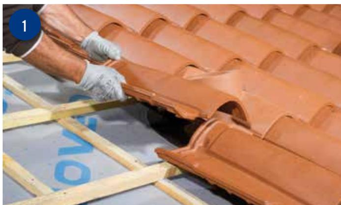
1 Déterminer le positionnement final de la tuile à douille. Enlever les tuiles du rang supérieur ainsi que la tuile voisine recouvrant la tuile à douille.
