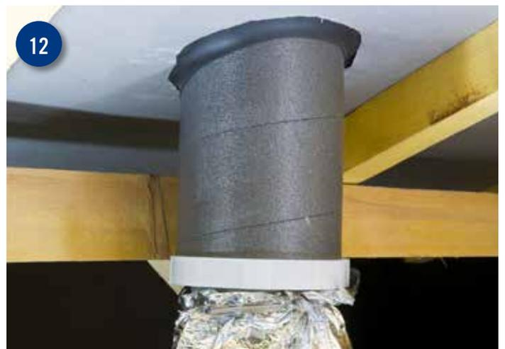
12 Le kit est désormais prêt à être raccordé à la gaine. Dans le cadre d'un raccordement gaine sur le diamètre 160mm, il est impératif de découper le diamètre 125mm du raccord jusqu'au pas de vis.
