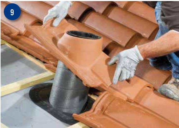
9 Positionner le kit à l'endroit prévu. Vérifier le bon contact de la collerette sur la tuile à douille. Si besoin tourner le manchon.
