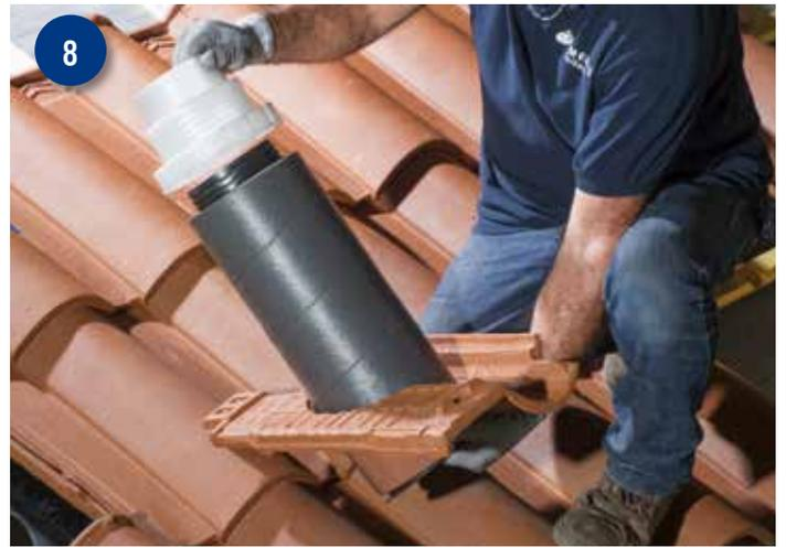
8 Mettre le manchon dans la tuile à douille, puis l'isolant et visser le raccord multi-diamètres. Veillez à placer le repère vers le faîtage, la collerette doit se poser correctement sur la douille. Fixer temporairement le collier de serrage autour du raccord.
