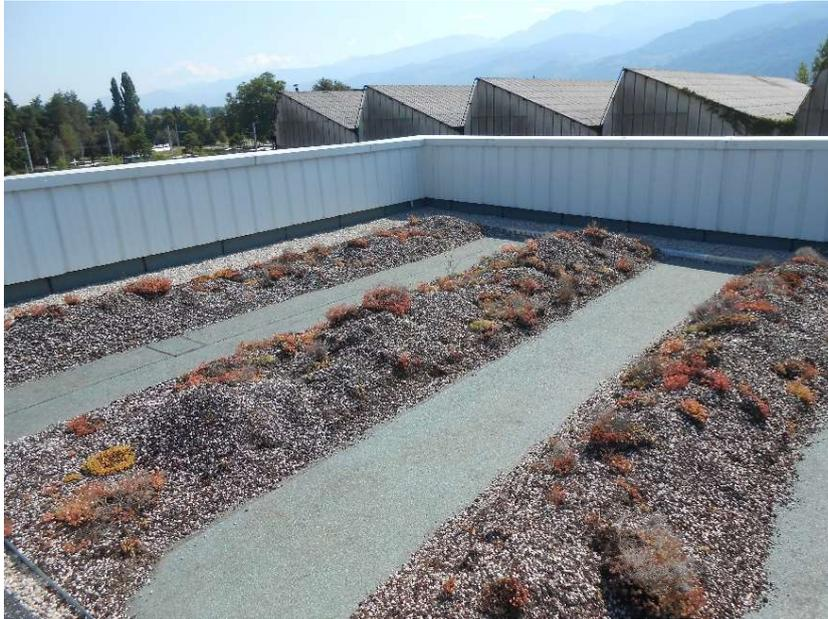
Dans le cas de pose en toiture ayant une étanchéité à membrane ou bitume et avec recouvrement de granulats, il est conseillé de retirer les granulats de la surface de pose du FLA SEMELLE TOP PV : 092476 (PRT0P00534A). Réaliser ensuite la pose suivant la notice. Puis une fois tous les raccordements effectués, étendre le gravier dans les zones où les granulats ont été retirés.
