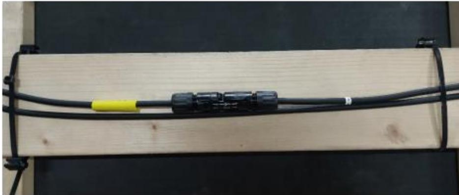
**Figure 34 – Cheminement des câbles sous les cadres polymère, sur les planches support et leur fixation par collier de câblage**
