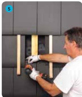
5 Retirer les vis de fixation de la tuile inférieure
