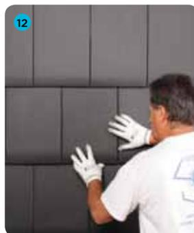
12 Finir la mise en place de la tuile de remplacement
