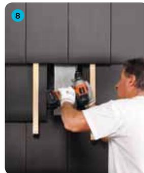
8 Fixer la platine en partie haute dans le liteau support de bardage
