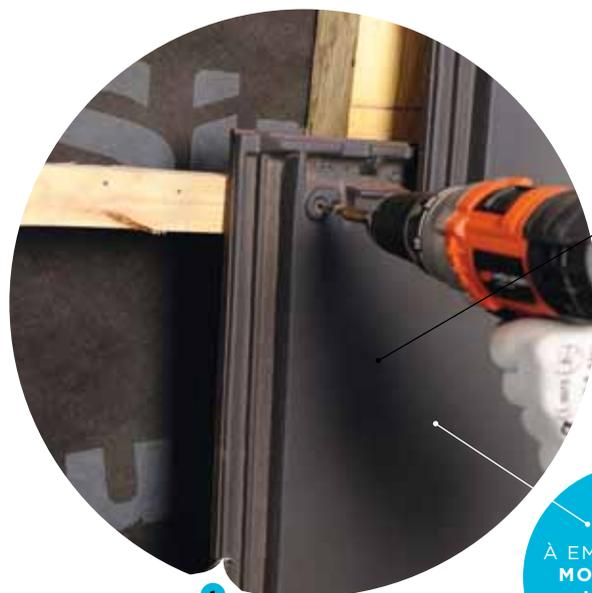
Toutes les tuiles sont fixées en partie haute par une vis au minimum et en partie basse par un crochet.
