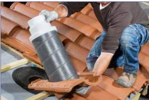
3. Mettre le manchon dans la tuile à douille, puis l'isolant et visser le raccord multi-diamètres. Fixer le collier de serrage autour du raccord.
