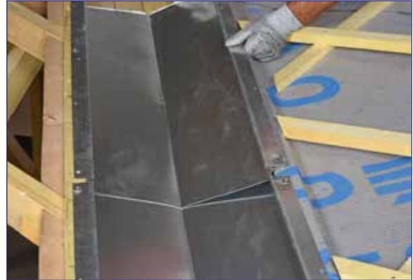
2. Après avoir préparé le pied de noue en découpant la partie basse en alignement de la ligne d'égout, les noues sont emboîtées de bas en haut en respectant le recouvrement de 15 cm.
