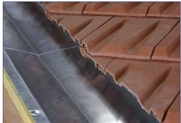
4. Avant d'être posées, les tuiles sont découpées parallèlement à l'axe de la noue. Elles doivent être fixées à leur support et respecter le recouvrement minimal prévu de leur DTU de référence.
