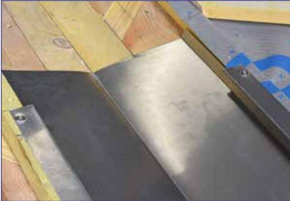
1. Le litage ainsi que les liteaux filants sont réalisés conformément aux prescriptions DTU. L'emploi d'une fonçure est possible et devra dans le cas d'absence d'écran de sous toiture être mise en œuvre dans le plan des chevrons.
