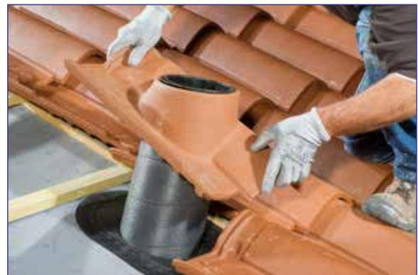
4. Positionner l'ensemble en s'assurant de la bonne étanchéité avec la membrane (si nécessaire, suivant la configuration de pose et du modèle de tuile, prévoir une découpe de la mousse). Finir en positionnant la grille anti intrusion et fixer la lanterne avec un mastic de collage sur la tuile à douille.
