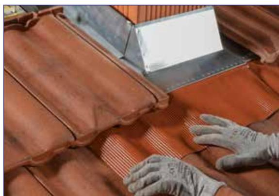
4. Maroufler la bavette plomb sur la première rangée de tuiles puis repositionner les tuiles périphériques avec un espace d'écoulement des eaux pluviales supérieur à 8 cm. Finir l'ouvrage en tirant un joint mastic entre le boisseau et l'abergement.
