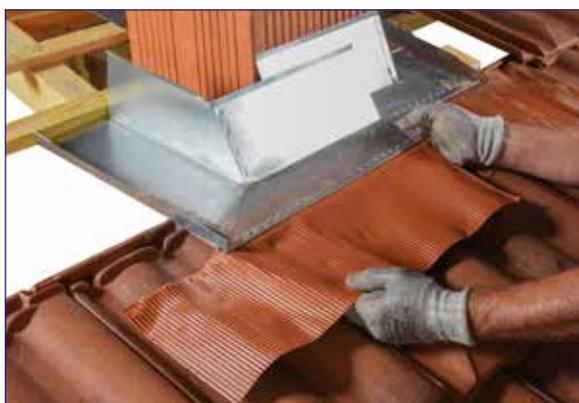
1. Mettre en place les 4 pièces de l'abergement et les resserrer autour du boisseau. Vérifier que les pièces arrières recouvrent celles avant d'au moins 30 cm.
