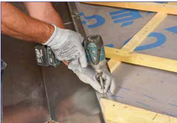
3. La fixation s'effectue sur les liteaux filants dans les trous de fixation oblongs conçus à cet effet.
