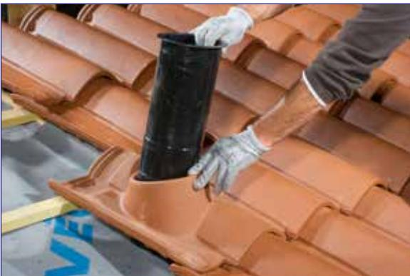
1. Déterminer le positionnement final de la tuile à douille à l'aide du manchon puis repérer le point de découpe de l'écran de sous-toiture.
