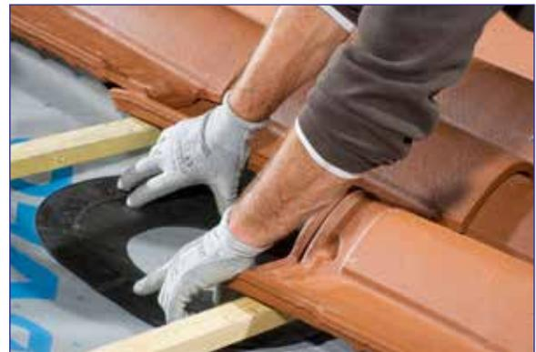
2. Positionner la membrane à l'aide du repère précédent et tracer la zone de découpe centrale. Puis découper l'écran de sous-toiture au niveau de la zone repérée et fixer la membrane à l'aide de l'adhésif.
