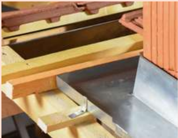
3- Fixer l'abergement avec des pinces en zinc et clous adaptés.
