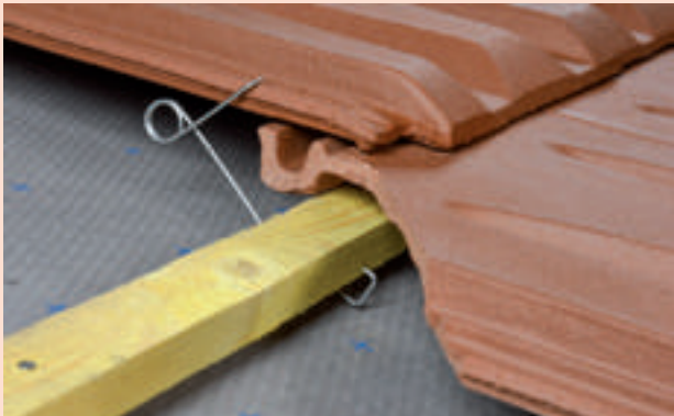
4- Déposer le crochet dans l'emboîtement de la tuile pour assurer la fixation.
