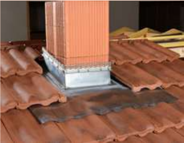
6- Repositionner les tuiles périphériques.
