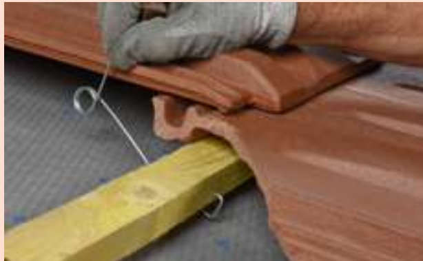
3- La mise en œuvre peut se faire aussi facilement à la main.
