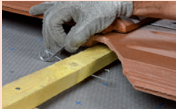
1- Crochet à harponner en sous face du liteau.
