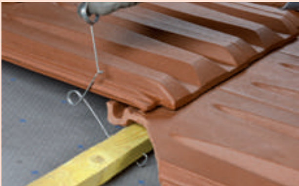
2- Partie supérieure à reprendre avec l'outil fourni pour plus de facilité et rapidité.
