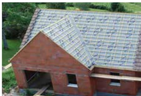
Pour toujours mieux préserver le bâti, EDILIANS a conçu une large gamme d'écrans de sous-toiture, pare-pluie et pare-vapeur. Ces produits hautement perméables et innovants à haute performance d'étanchéité respectent scrupuleusement les normes en vigueur pour une protection optimale.
