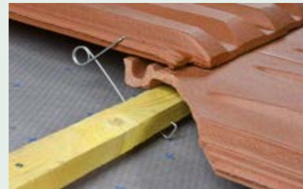
3- Déposer le crochet dans l'emboîtement de la tuile pour assurer la fixation
