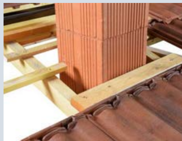
1- Retirer les tuiles autour du boisseau ou de la souche de cheminée.
