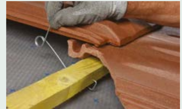
2- Tirer la partie supérieure du crochet vers le haut
