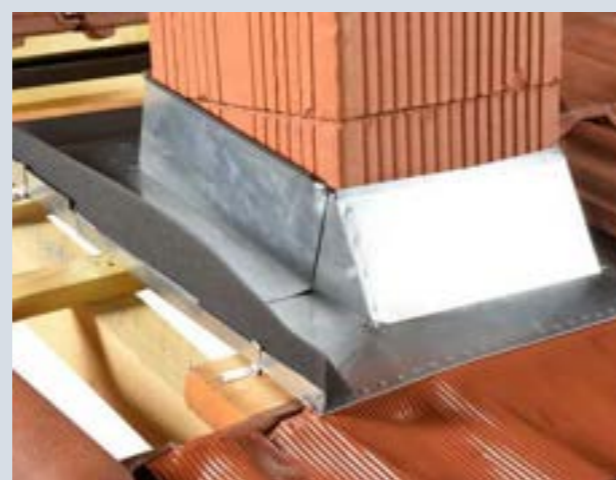
4- Après avoir soudés les 4 éléments, coller le joint mousse sur le pourtour de l'abergement.
