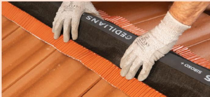
1 - Après avoir positionné la lisse de rehausse dans l'axe du faitage, dérouler et positionner le closoir sur celle-ci.
