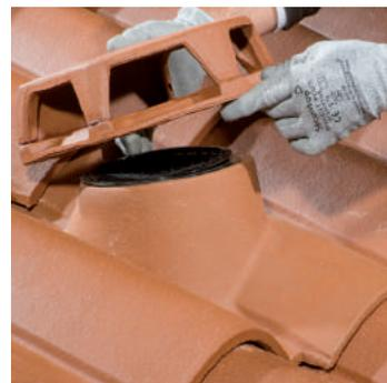
**8** - Positionner la grille anti intrusion et fixer la lanterne avec un mastic de collage sur la tuile à douille.
