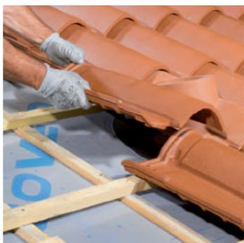
**1** - Déterminer le positionnement final de la tuile à douille. Enlever les tuiles du rang supérieur ainsi que la tuile voisine recouvrant la tuile à douille.
