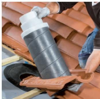
**6** - Mettre le manchon dans la tuile à douille, puis l'isolant et visser le raccord multi-diamètres. Fixer le collier de serrage autour du raccord.
