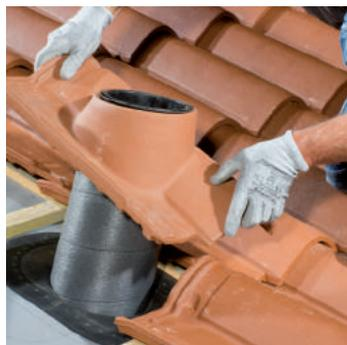
**7** - Positionner l'ensemble en s'assurant de la bonne étanchéité avec la membrane (si nécessaire, suivant la configuration de pose et du modèle de tuile, prévoir une découpe de la mousse).
