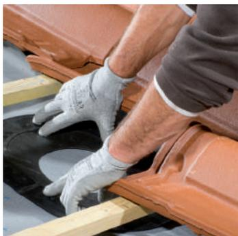
**5** - Découper la zone, sur l'écran de sous toiture, repérée préalablement. Fixer la membrane à l'aide de l'adhésif.
