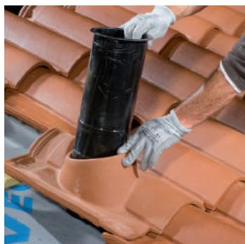
**2** - Positionner correctement le manchon au centre de la tuile à douille. Le sens d'inclinaison du manchon est indiqué par un repère.
