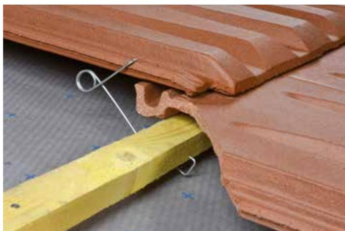
4 - Déposer le crochet dans l'emboîtement de la tuile pour assurer la fixation.
