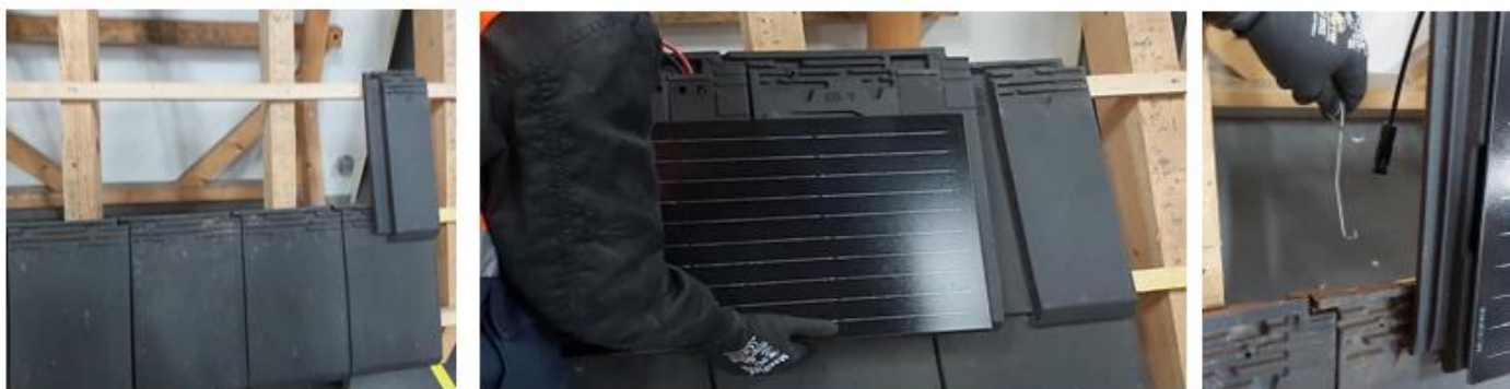
Figure 24 – Mise en œuvre en toiture
