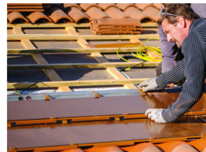
Pose directe sur liteaux de la TUILE SOLAIRE MAX et OMEGA 13 Ste Foy - COLORIS ROUGE
