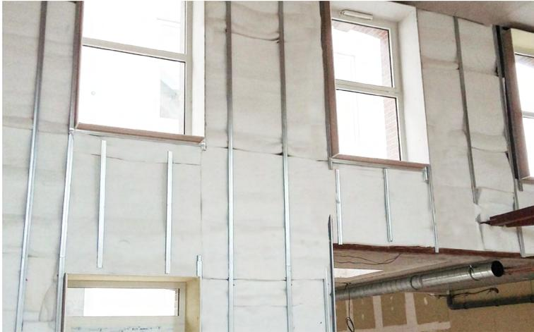
L'isolant EcoPeg est une laine de polyester qui possède des **propriétés thermo-acoustiques**. Sa liaison est faite **thermiquement** et **mécaniquement** : sans liants chimiques, sans adjuvants, sans sel de bore, sans ignifugeants, sans pesticides et sans fongicides.
