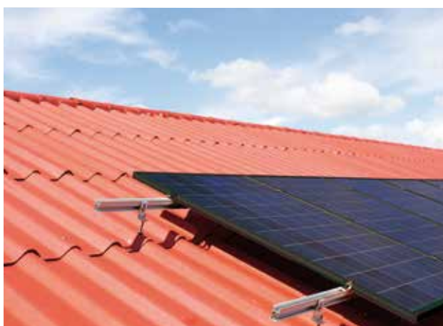
Tôle ondulée et fibro
