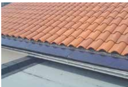
Pose à l'égout
