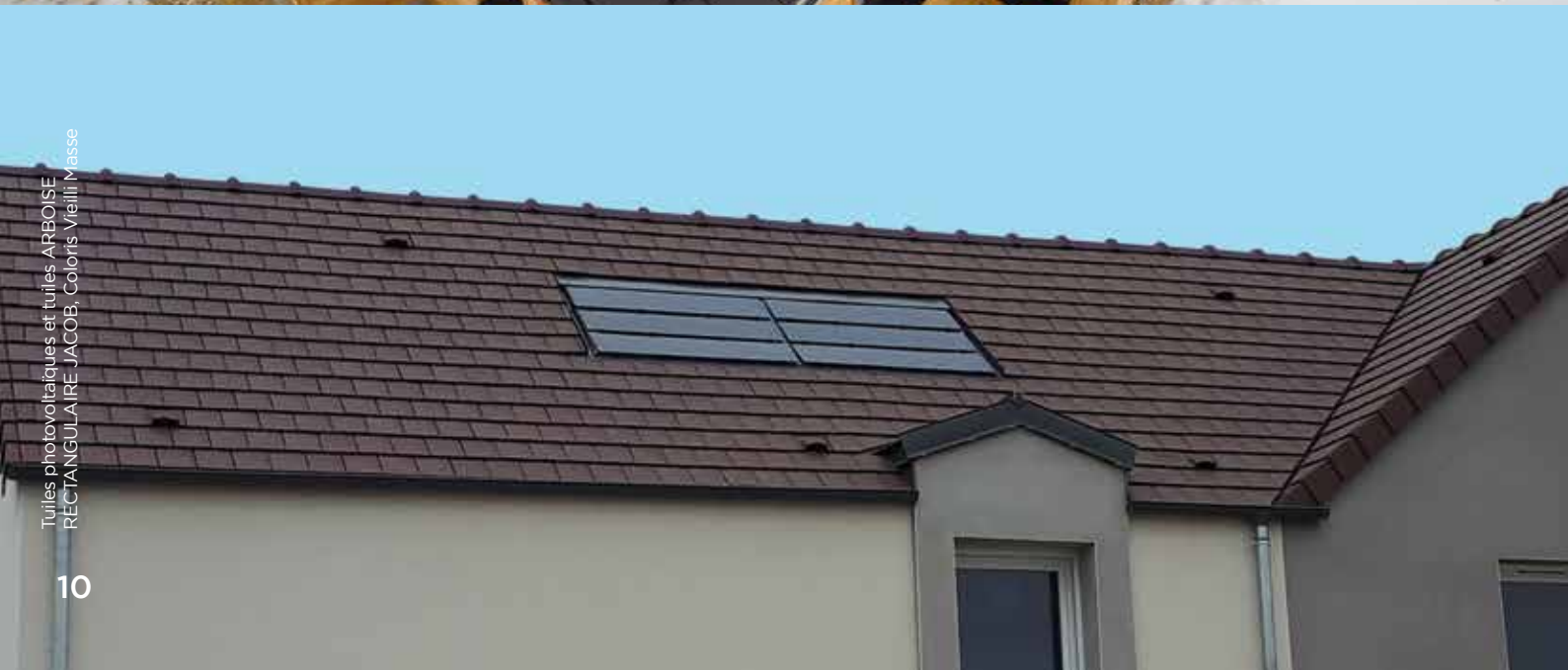
Tuiles ALPHA SOLAIRE et Tuiles ALPHA 10 Ste-Foy coloris ardoise. Mise en oeuvre Entreprise Bourguignon. Crédit Photo : Loti Lagneau
