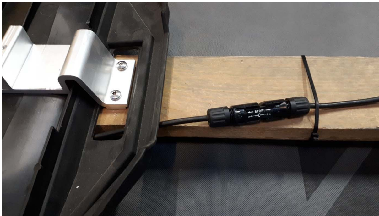
Figure 25 – Cheminement des câbles sous les cadres polymère et leur fixation par collier de câblage
