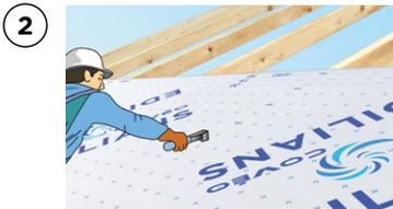
2 Agrafer dans la future zone de recouvrement et non pas dans la partie courante de l'écran.
