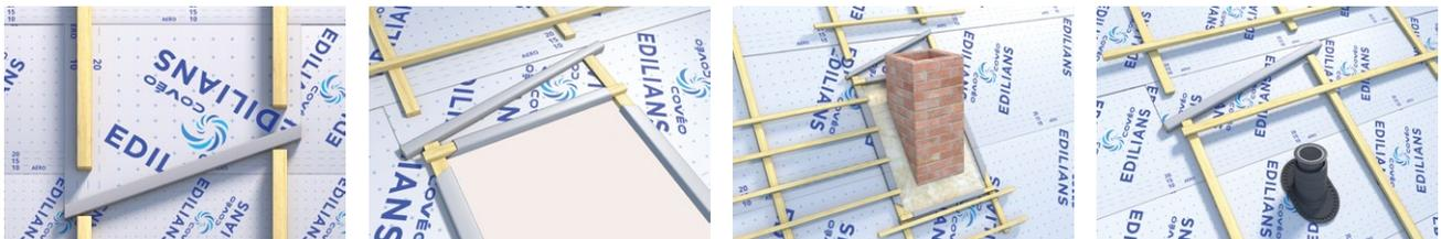
L'objectif est de dévier l'eau qui est sur la trajectoire de points singuliers à risque de pénétration, pour cela, on crée un « déflecteur » en enroulant un morceau de lés d'écran autour d'un liteau placé à 45°. Une fois le déflecteur mis en place l'eau est déviée sur la travée adjacente. Le bout d'écran enroulé autour du liteau doit être placé en partie haute sous le lés d'écran supérieur.
