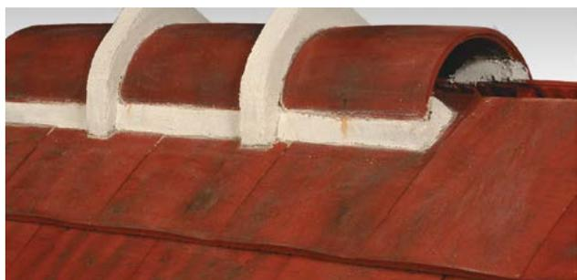
Faîtage scellé avec faîtières 1/2 rondes sans emboîtement. Crêtes et embarrures réalisées au mortier (D.T.U. 40.23. art 3.4).
