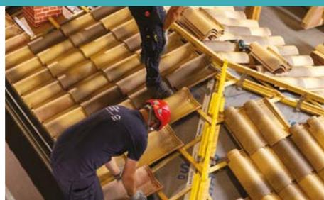
Poser les tuiles en escalier au niveau de l'arêtier
