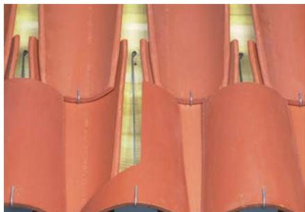
Fixation des tuiles de couvert du 1<sup>er</sup> rang d'égout, par crochets longs à œil Réf. CRCAN.550
