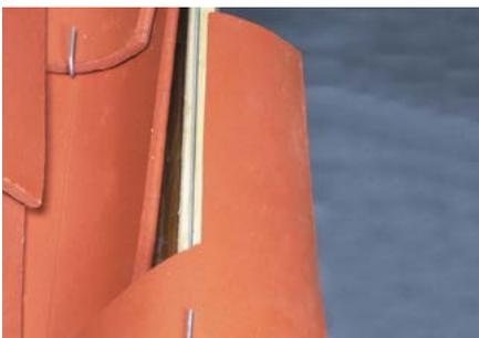
Fixation des tuiles de couvert du 1<sup>er</sup> rang d'égout en rive latérale gauche et droite par crochets longs à œil - Réf. CRCAN.550.
