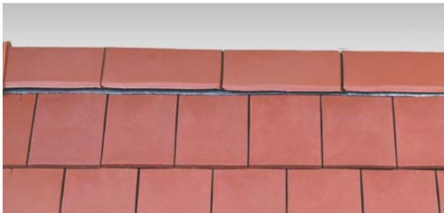
Faîtage réalisé à sec avec faîtières angulaires à emboîtement grand modèle et closoir ventilé, sans emploi de mortier. Après mise en place du closoir ventilé, les faîtières sont fixées par crochet adapté au modèle, vissé dans la lisse de rehausse.
