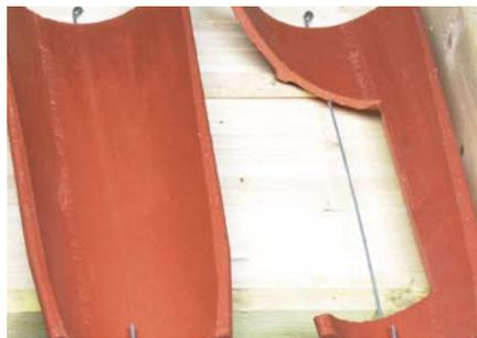
Fixation des tuiles de courant à tenons du 1<sup>er</sup> rang d'égout, en rives latérales gauche et droite par crochets longs à œil Réf. CRCAN.550. La fixation des crochets s'effectue facilement sur le support ou sur les chevrons.
