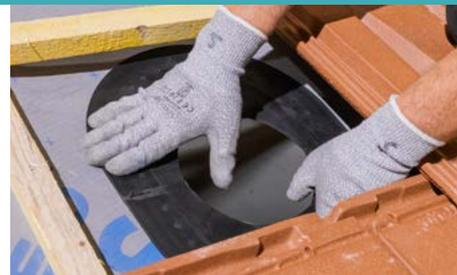
▲ Fixer la membrane autoadhésive sur l'ouverture réalisée dans l'écran
