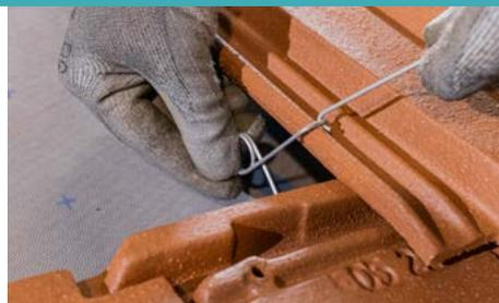
Pour réaliser le premier rang d'égout, poser les tuiles de droite à gauche et les fixer individuellement
