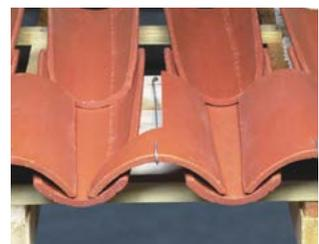
Fixation des tuiles de couvert du 1<sup>er</sup> rang d'égout, par crochets longs à œil Réf. CRCAN.550
