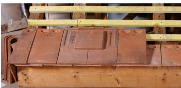
Au 1<sup>er</sup> rang uniquement, pose alternée de la tuile NÉOPLATE Ste Foy et de la tuile PLATE PRESSÉE 17X27 Ste Foy.
