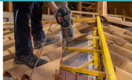
Découper les tuiles suivant le tracé, retirer les chutes et réserver les tuiles coupées
