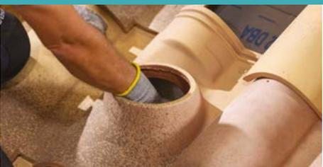
Positionner la tuile à douille et tracer la découpe de sortie VMC sur l'écran de sous-toiture
