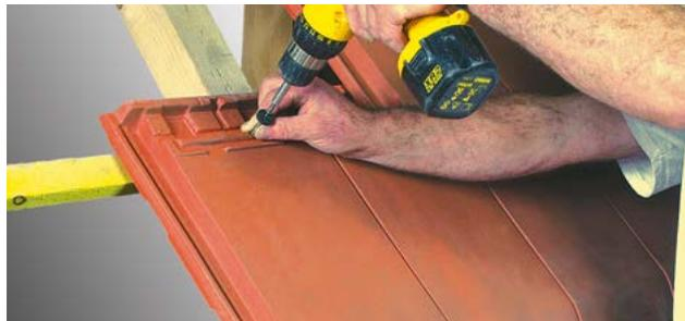
Fixation des tuiles en plain carré pour tenue à forte pente, par vis et rondelle d'étanchéité.
