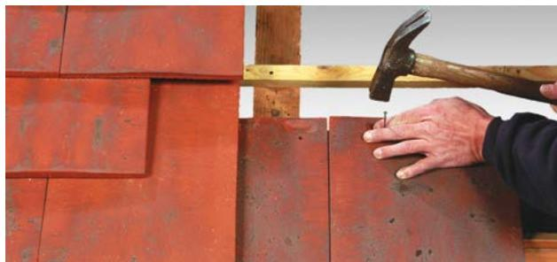
Fixation des tuiles courtes du 1<sup>er</sup> rang d'égout, par clou.
