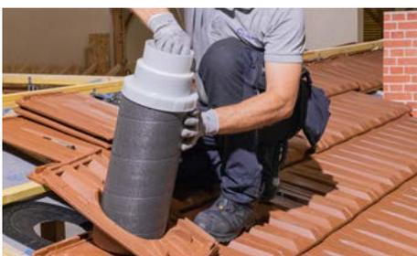
▲ Mettre le manchon dans la tuile à douille, puis l'isolant et visser le raccord multi-diamètres
