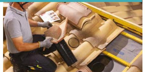
Mettre le manchon dans la tuile à douille, puis l'isolant et visser le raccord multi-diamètres
