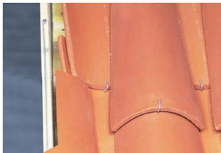
Fixation des tuiles du 1<sup>er</sup> rang d'égout en rives latérales gauche et droite, par crochets longs à œil - Réf. CRCAN.550
