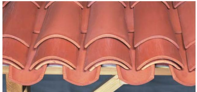
Mise en œuvre à 2 tuiles en pose à "joints décalés". Les tuiles CANAL Poudenx sont posées à recouvrement sur les sommets et dans les creux d'onde des plaques.
