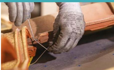
Fixer les tuiles des rangs supérieurs avec les crochets
