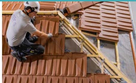
Utiliser le cordeau de traçage pour tracer la découpe des tuiles intermédiaires
