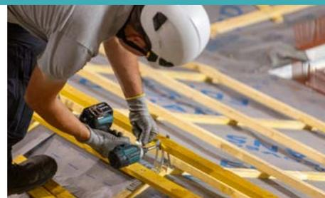
Positionner les supports de latte au niveau du faîtage et les fixer sur les contrelattes
