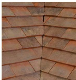
Réaliser les approches de cette noue fermée en PLATE PRESSÉE 17X27 Ste Foy.
