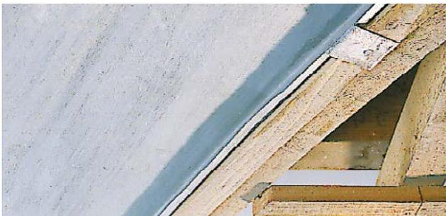
Mise en place de la noue métal façonnée à relevés, contre liteau filant et patte de fixation.
