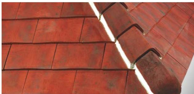
Arêtier scellé avec arêtiers et about d'arêtier angulaire petit modèle sans emboîtement.
