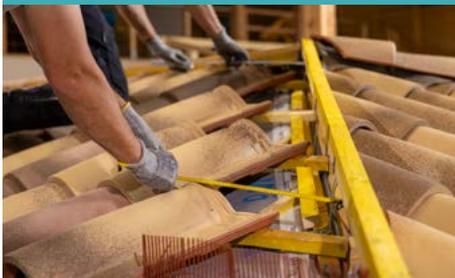
Mesurer la largeur de 2 tuiles et reporter cette largeur sur les tuiles posées en escalier
