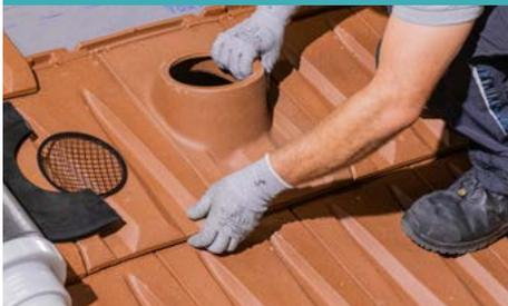
▲ Positionner la tuile à douille et tracer la découpe de sortie VMC sur l'écran de sous-toiture
