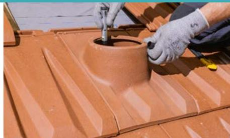
▲ Tracer correctement la découpe à effectuer à l'aide de la membrane si besoin
