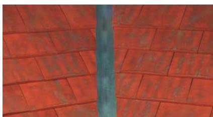
2. Les tuiles sont tranchées biaises, parallèlement à l'axe de la noue.
