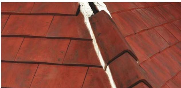
Après coupe des tuiles d'approche, mise en œuvre des arêtiers angulaires petit modèle sans emboîtement, utilisation de mortier (D.T.U. 40.23. art 3.4).
