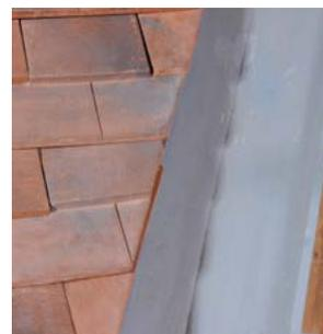
Réaliser une noue classique avec couloir zinc ; puis fixer les tuiles à l'aide d'un des 2 trous de pré-perçage.
