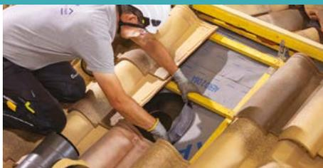
Fixer la membrane autoadhésive sur l'ouverture réalisée dans l'écran
