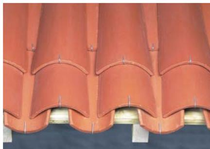
Réalisation d'un 1<sup>er</sup> rang d'égout à «rang décalé». Ce principe de mise en œuvre n'exclut pas la fixation des tuiles de courant et de couvert en rives et en égout suivant les cas précités. Cette mise en œuvre peut s'effectuer sur support continu ou sur liteaux.
