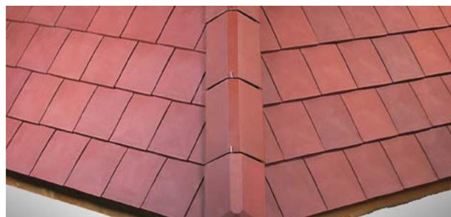
Arêtiers et about d'arêtier angulaire à emboîtement posés à sec, sans emploi de mortier.
