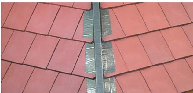
Après coupe des tuiles d'approche, pose d'une bande métallique ou adhésive découpée, avec remontée sous tuile et sur lisse de rehausse.
