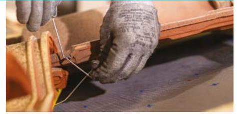
Poser les tuiles des rangs supérieurs et les fixer à l'aide des crochets
