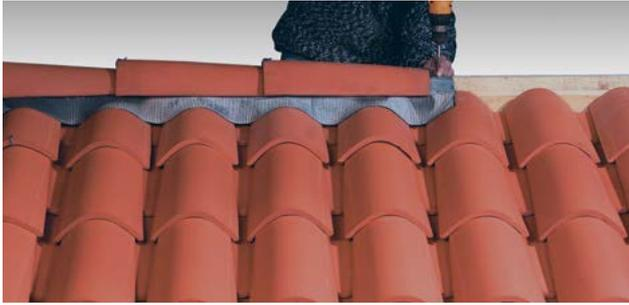
Après mise en place du closoir ventilé, les faitières sont fixées par crochet adapté au modèle, vissé dans la lisse de rehausse.
