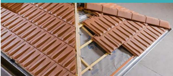
Poser 2 tuiles supplémentaires par rang, installer la tuile coupée le long de l'arête, puis procéder de la même manière sur les autres rangs pour chaque côté de l'arête
