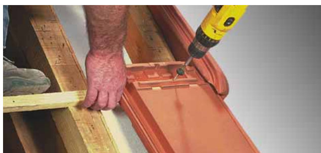
Fixation des tuiles en rives latérales gauche et droite par vis et rondelle d'étanchéité.
