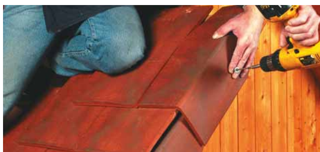
Mise en œuvre des rives individuelles gauches et droites, posées un rang sur deux et fixées par vis et rondelles d'étanchéité.
