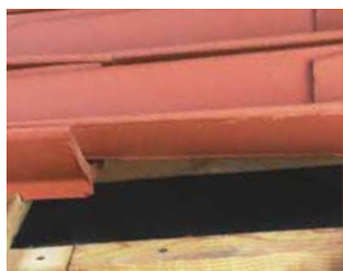
Fixation des tuiles de courant en plain carré par les tenons des tuiles. La fixation en référence au tableau n° 5 du DTU 40.22 art. 3.333 est assurée par les tenons des tuiles.
